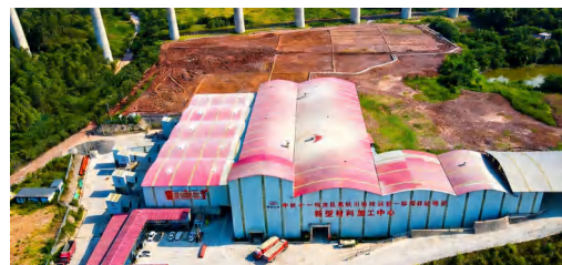
中铁十一局·渝昆高铁·重庆九龙坡段
