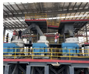
设备安装调试
